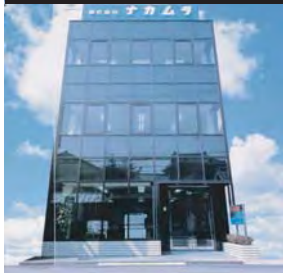
昭和60年 豊中市本社ビル改築
